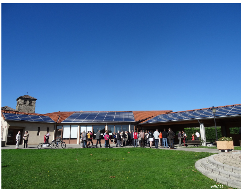
"la centrale villageoise photovoltaïque des Haies en fonction depuis 2014"
